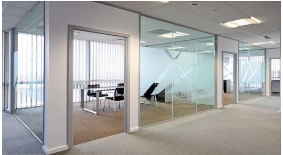
Oltre a creare aree riservate al solo personale autorizzato, tramite soluzioni specifiche con l'utilizzo di porte a battente o porte scorrevoli, si andrà a progettare e personalizzare ogni tipologia installativa in funzione degli ambienti e delle reali necessità/esigenze della stazione appaltante (parete divisoria interamente in vetro, pareti divisorie con pannellatura cieca, parete divisoria con finestra vetrata etc.).
